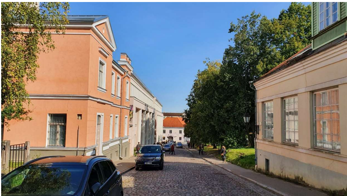
Pilt 23. Vasemal Lossi tn 9 ja paremal Lossi tn 24 hoone, vaade läänest. Pilt Mart Hiob 2020.
